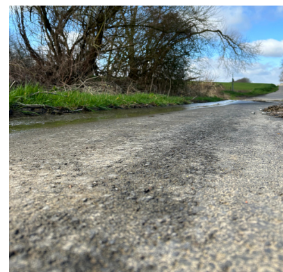
Empierrement au chemin de l'Indicateur à Epinois
