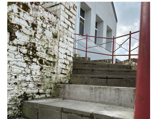
Réparation de l'escalier de l'école communale de Bray-Cité
