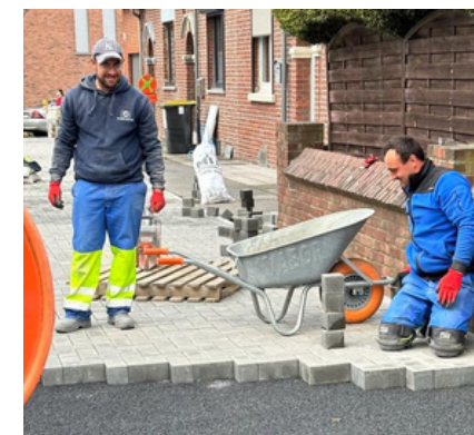
Nouveaux trottoirs pavés à la rue des Anémones à Ressaix
