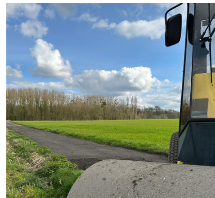
Suite des travaux d'empierrement de la voie Miclette à Waudrez
